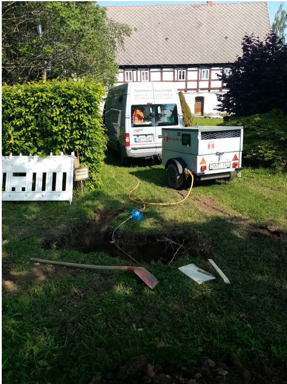
Die Firma Teichmann stellt einen Hausanschluss mittels Erdrakete her
