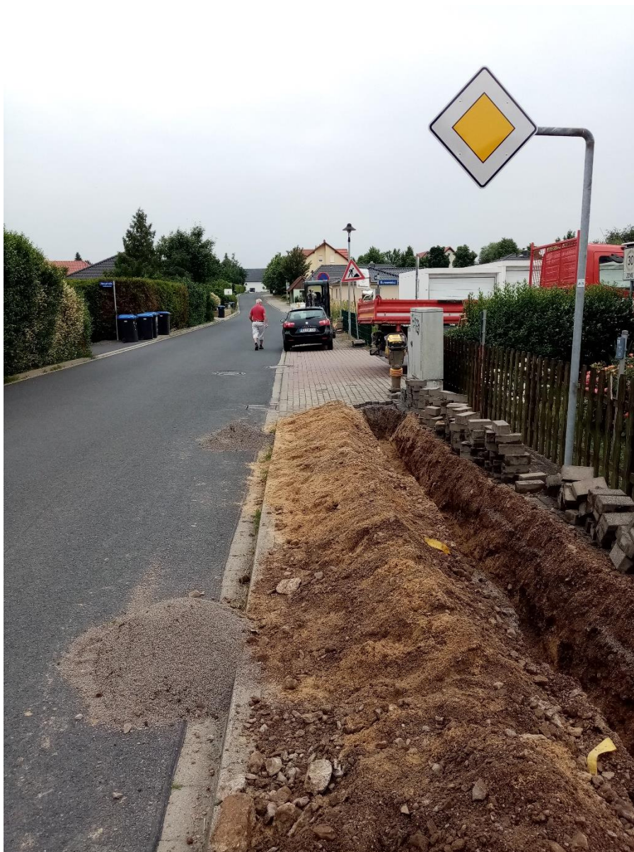
Graben für Breitband in der Bergstraße in Klipphausen
