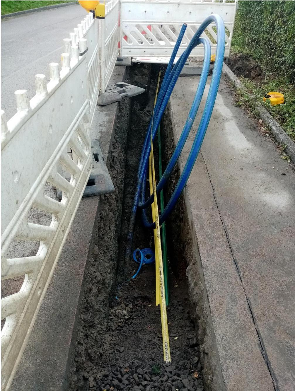
Auch in Grotzsch sind die Ausbauarbeiten in vollem Gange. Entlang der Tanneberger Straße wird neben den Breitbanderrohrverbänden eine Trinkwasserleitung mitverlegt.
