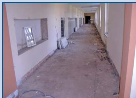
Umbau Kita Miltitz
