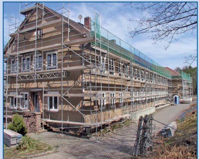
Umbau Kita Miltitz
