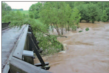
Holzbrücke über die Triebisch in Roitzschen Weg zur Kläranlage
