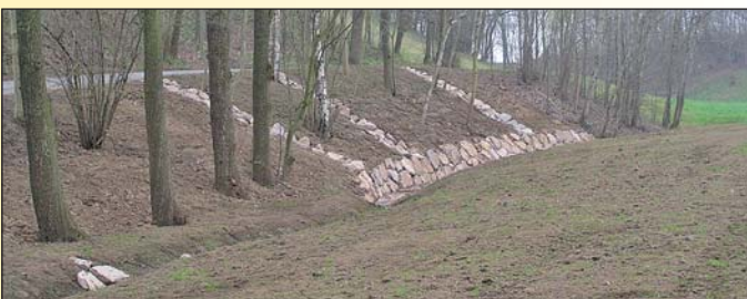
Böschungssicherung Gävernitz
