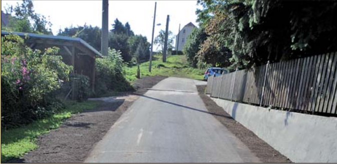
Straßenbau in Bockwen
