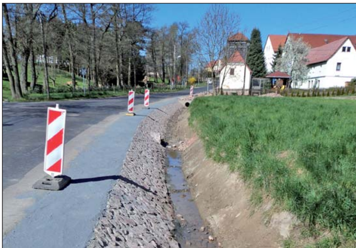
Instandsetzung Bachlauf Röhrsdorf
