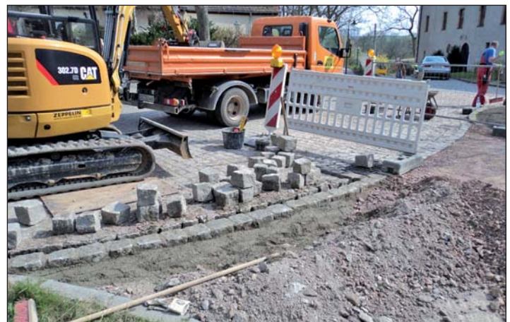
Erweiterung RW-Kanal Batzdorf
