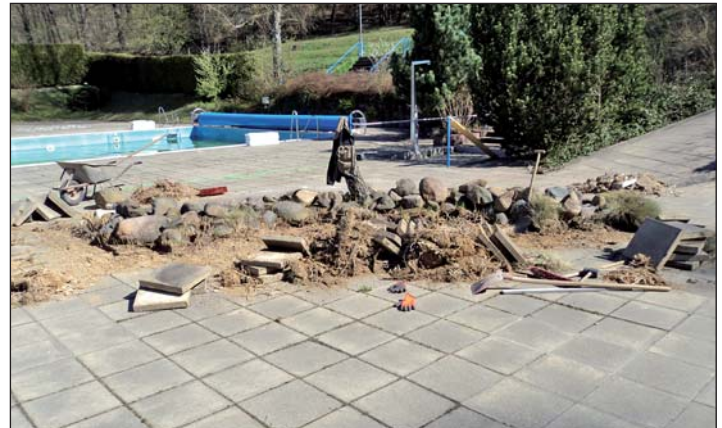
Erneuerung der Platten im Jahnbad Miltitz
