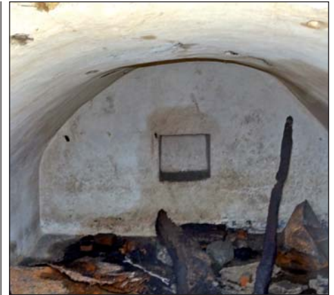
B 08 Kellerraum, Zustand 04/2015
