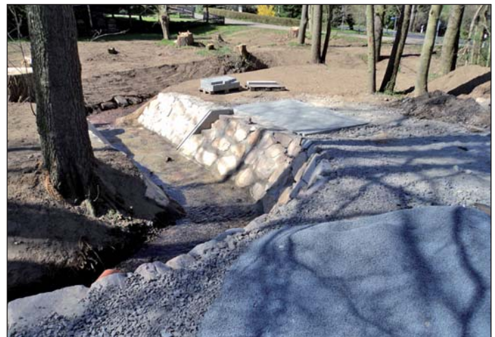
Sanierung Bachlauf Munzig
