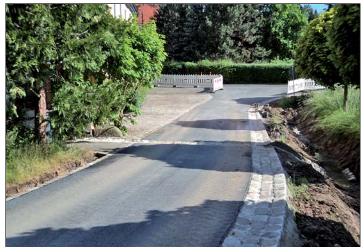
Zufahrtsweg FFW Sora
