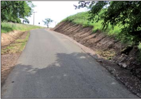
Ertüchtigung Entwässerungsrinnen Neudeckmühlenweg
