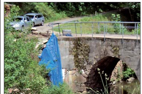
Sanierung Brücke Schlossmühle
