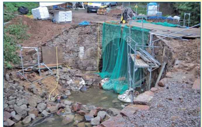
Brücke Schlossmühle Klipphausen
