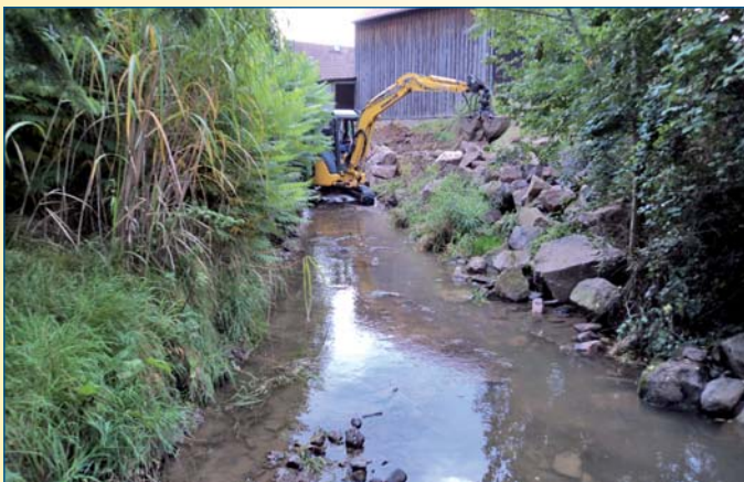
Gewässerinstandsetzung Kleine Triebisch Taubenheim
