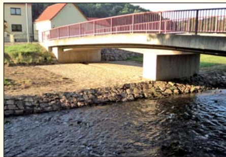
Brücke Lange Leite Roitzschen
