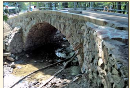
Brücke Lehmannmühle Klipphausen
