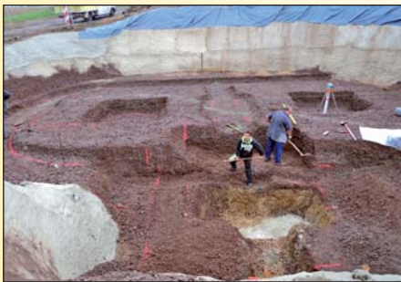
Bau TW-Hochbehälter Sora
