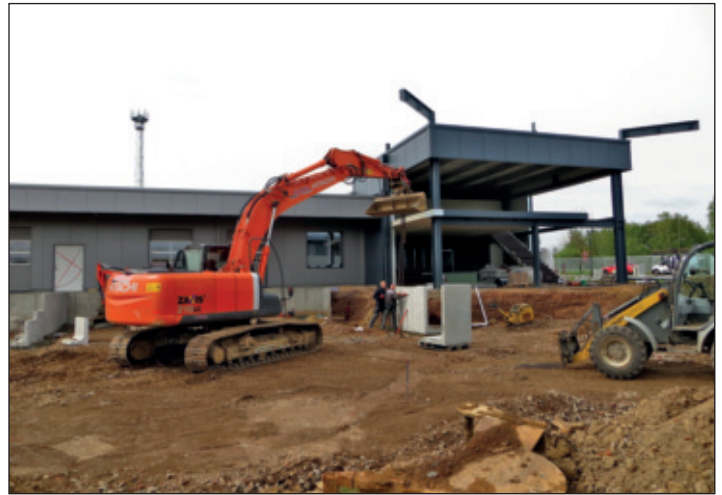
Bau des Gebäudes für das neue Unternehmen Gutes Essen – Nahrungsmittel GmbH. Handwerker aus der Region sind einbezogen. Die Firma Baustein Meißen GmbH ist jetzt bei der Gestaltung der Außenanlagen.
