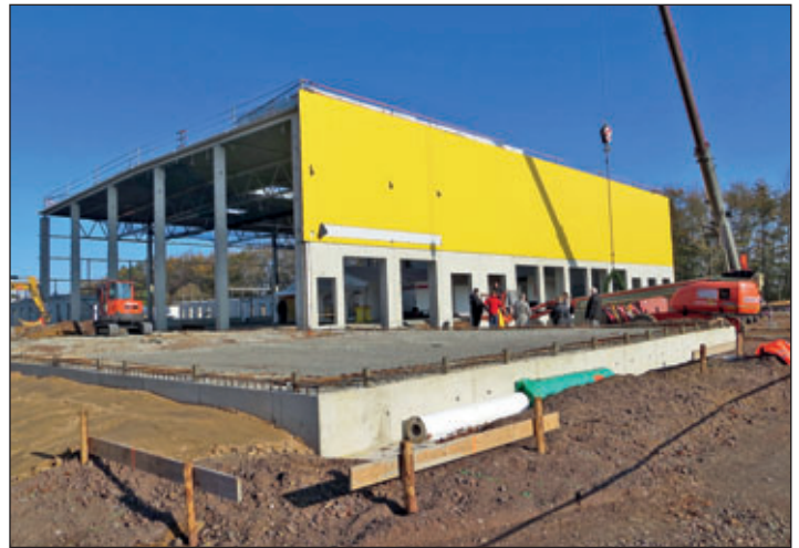
Seitenansicht des DHL-Neubaus.
