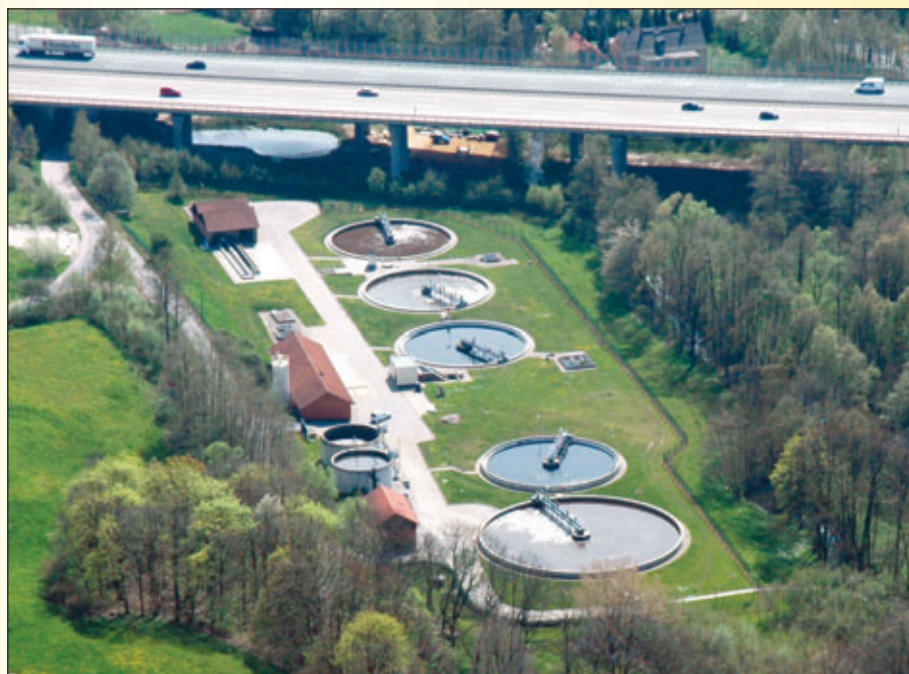
Die Kläranlage in Klipphausen
