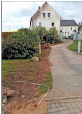
Verlegung eines Hausanschlusses in Sachsdorf
