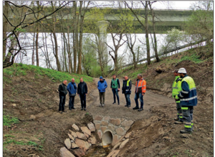
Auch der Einlauf des Krebsbaches in die Verrohrung durch den Straßendamm wurde neu gemacht.
