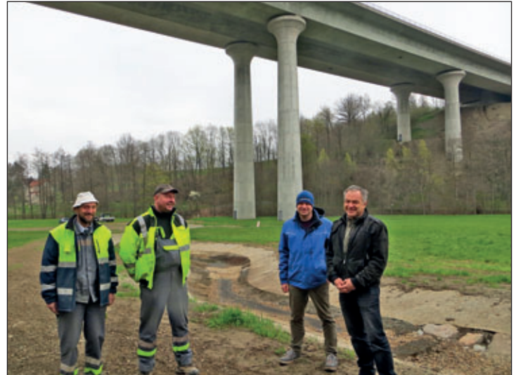
Haben guten Anteil an diesem Projekt, von links: die Bauleute Steffen Jacob und Heiko Winkler vom Baubetrieb Nitsche, Michael Hegenbart, Bauamtsleiter in der Gemeinde Klipphausen und Planer Olaf Nickel vom Ingenieurbüro Müller-Miklaw-Nickel aus Miltitz. Im Hintergrund die Triebischtalbrücke und der neue Bachlauf.
