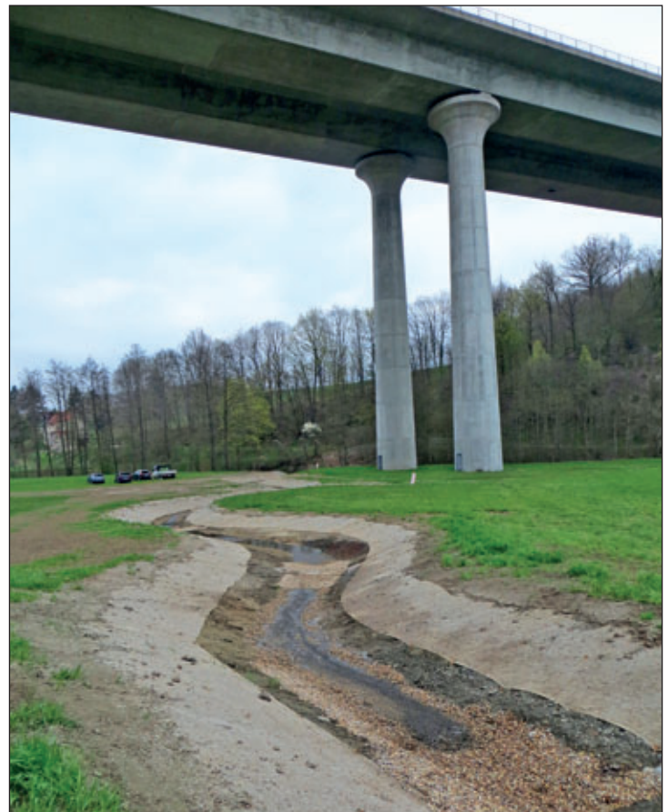
Der Krebsbach wurde an dieser Stelle wieder freigelegt.
