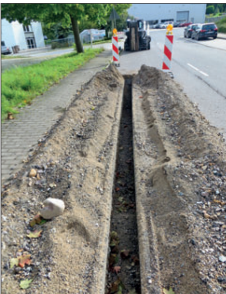
Der schmale Graben für die Glasfaserkabel, der mit dem Bobcat exakt ausgehoben wurde.
