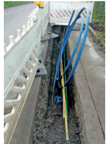
Auch in Groitzsch sind die Ausbauarbeiten in vollem Gange. Entlang der Tanneberger Straße wird neben den Breitbandleerrohrverbänden eine Trinkwasserleitung mitverlegt.
