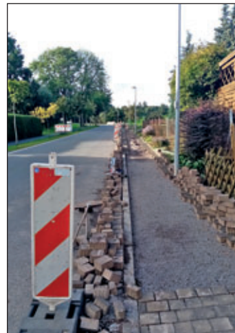
In Seeligstadt wird ein Teil der Trasse im Fußweg verlegt.
