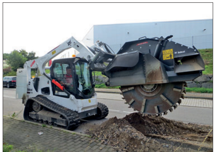
Gesamtansicht vom Bobcat. Das große Fräsrad ist mit über 70 Fräszähnen ausgestattet.
