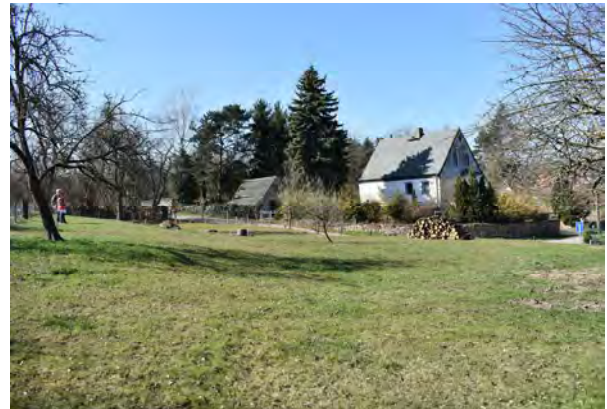
Abbildung 2 Blick aus Osten Richtung Hohle Gasse
