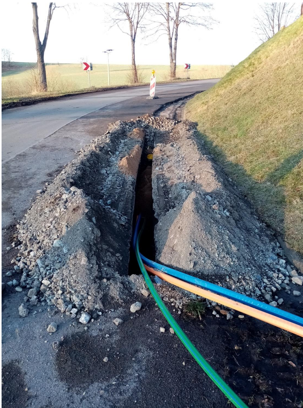
Das Bild zeigt das Grabenprofil der Fräse der Fa. Koch Straßen- u. Tiefbau, welche schon im Gewerbegebiet in Klipphausen zum Einsatz kam.
