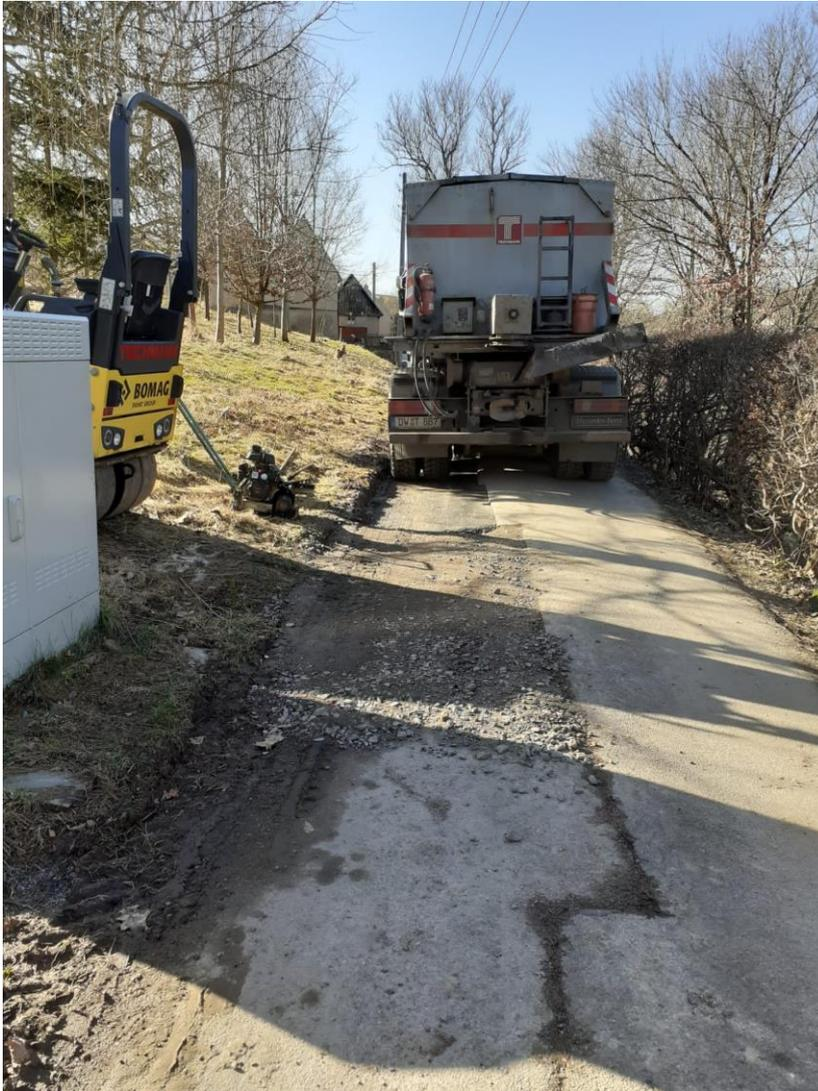
In Rothschönberg wird der Deckenschluss nach der Breitbanderrohrverlegung durchgeführt. Hier heißt es genau planen und den Wetterbericht im Auge behalten.
