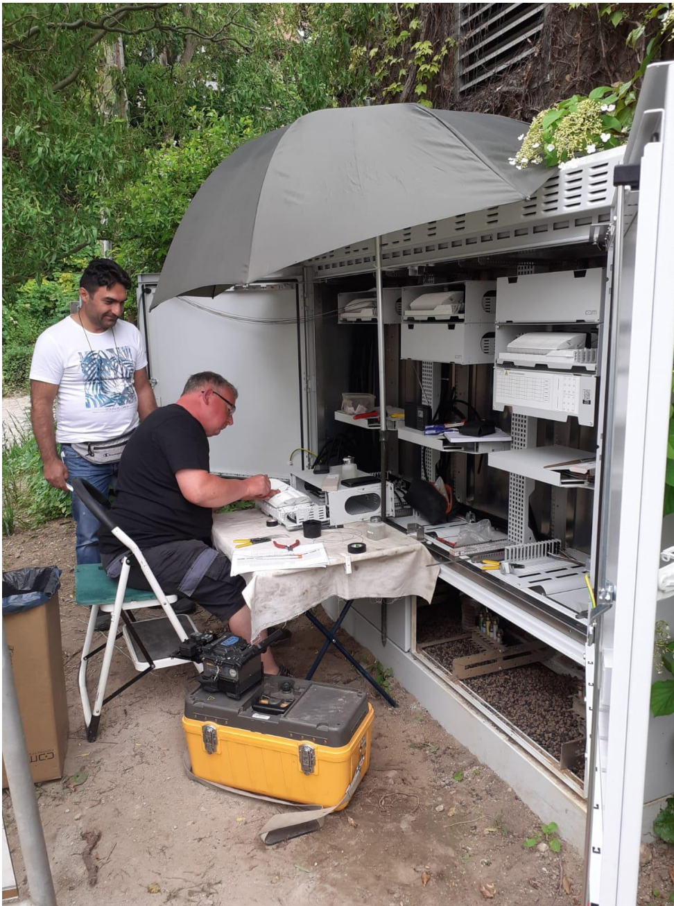
Ein Mitarbeiter der Rhönmontage Fernmeldebau GmbH konfiguriert einen AVt (oberirdischer Glasfaserverteiler) in Wildberg und Herr Sen von Seim & Partner überwacht die Arbeiten.
