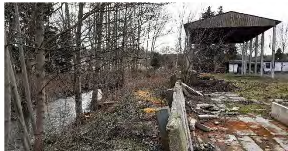
Abb.: Ehem. Bebauung an der Wilden Sau
