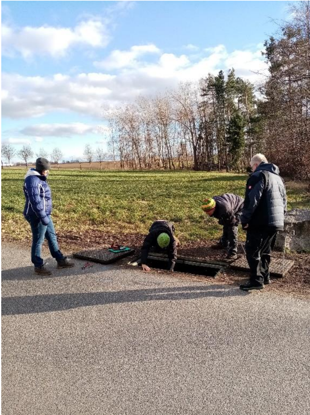
Frau Weger vom Netzbetreiber Vodafone und Herr Unger von Seim & Partner nehmen einen Muffenschacht in Taubenheim unter die Lupe. Das ist Teil der Abnahme der Verteilerbereiche.
