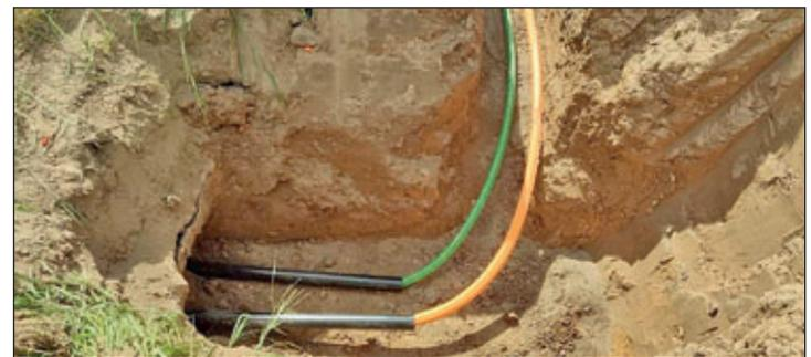
*zwei Leerrohrverbände sind in Erdraketenschutzrohr verlegt*
