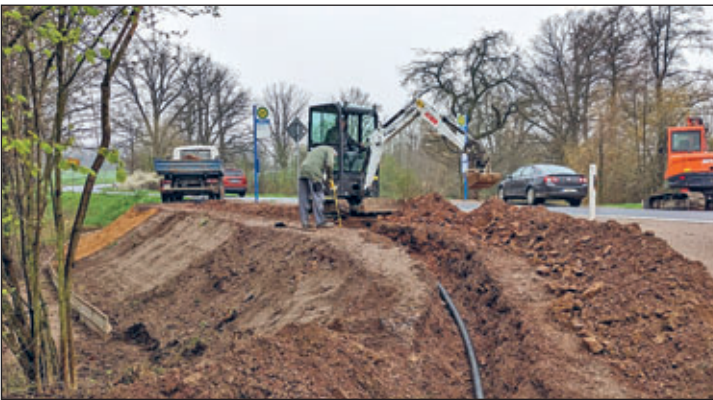
Kabelgraben für Straßenbeleuchtung
