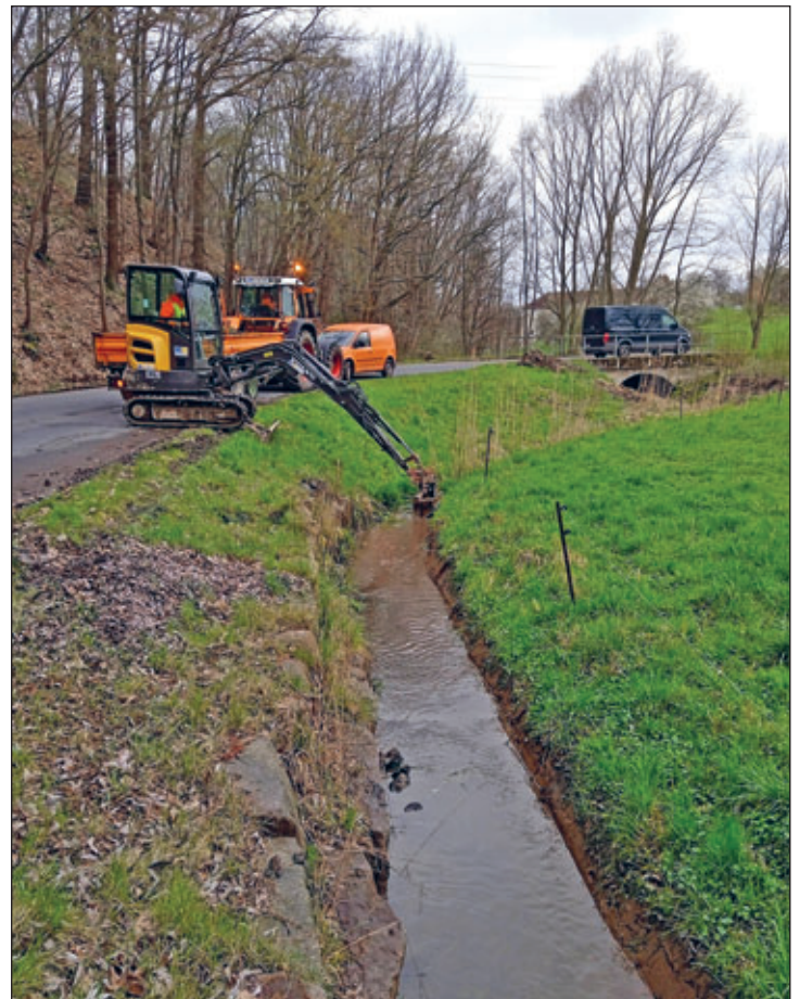
Ausheben des Bachlaufs
