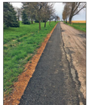
Eingebaute Asphalttragschicht
