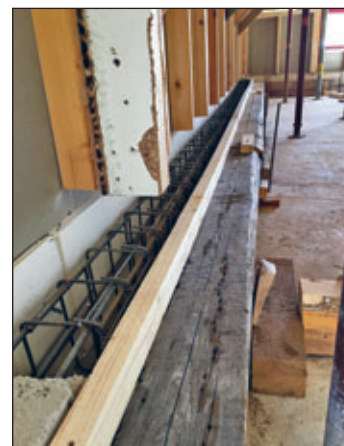
Schalung für Betonage im Sockelbereich
