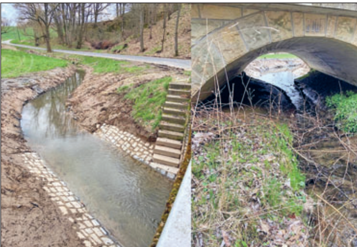
Brückendurchlass vor und nach den Baggerarbeiten
