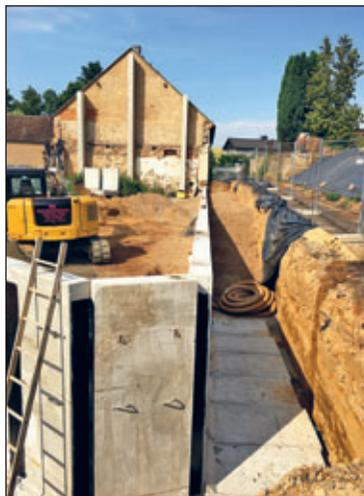
Sie wird bis Ende Juli die bis zu 2,80 m hohen Winkelstützelemente verlegt und die Straße in einen befahrbaren Zustand gebracht haben. Somit ist die Sicherheit für den anliegenden Anwohner- und Versorgungsverkehr wieder gewährleistet. Die Sicherungsmaßnahme dauert 1,5 Monate, kostet rund 170.000,00 € und wird über die pauschale Zuweisung des Freistaates Sachsen für Straßen finanziert. Eine für den Straßenerhalt gut angelegte Investition.
