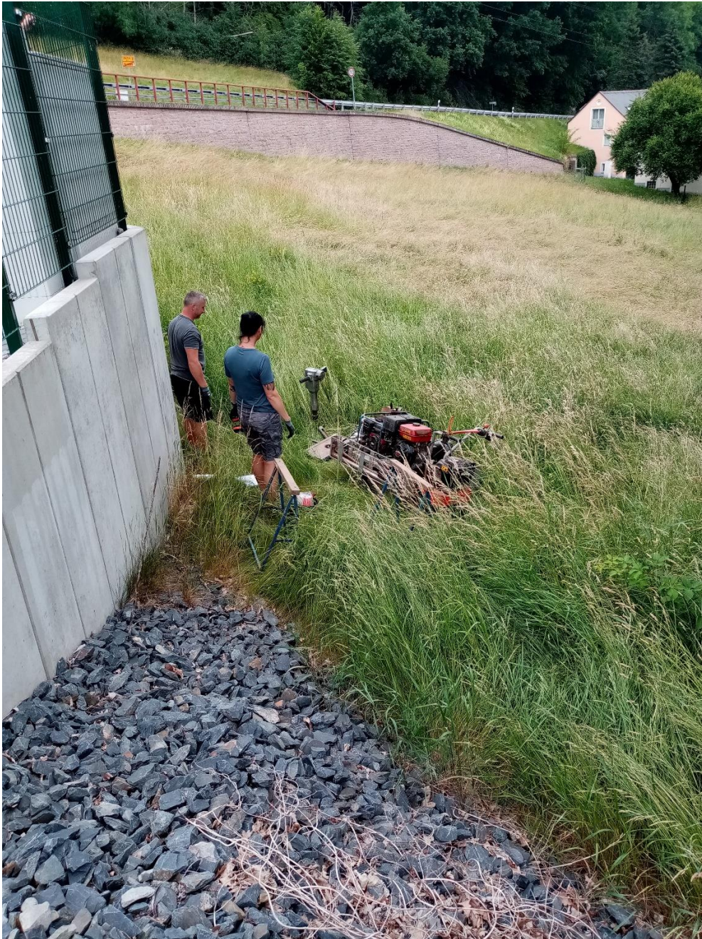
Mitarbeiter der Fa. Boden Kuntze GmbH aus Kleinschönberg führen in Garsebach die Baugrunduntersuchung für eine geplante Bahnquerung durch.
