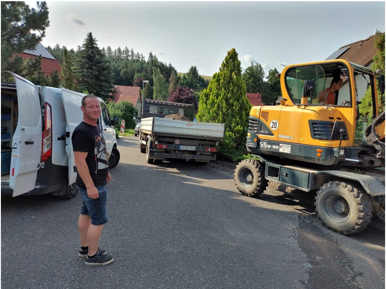
Heiko George vom Bauamt der Gemeinde Klipphausen kontrolliert den Baufortschritt vom Glasfaserausbau in Burkhardswalde.
