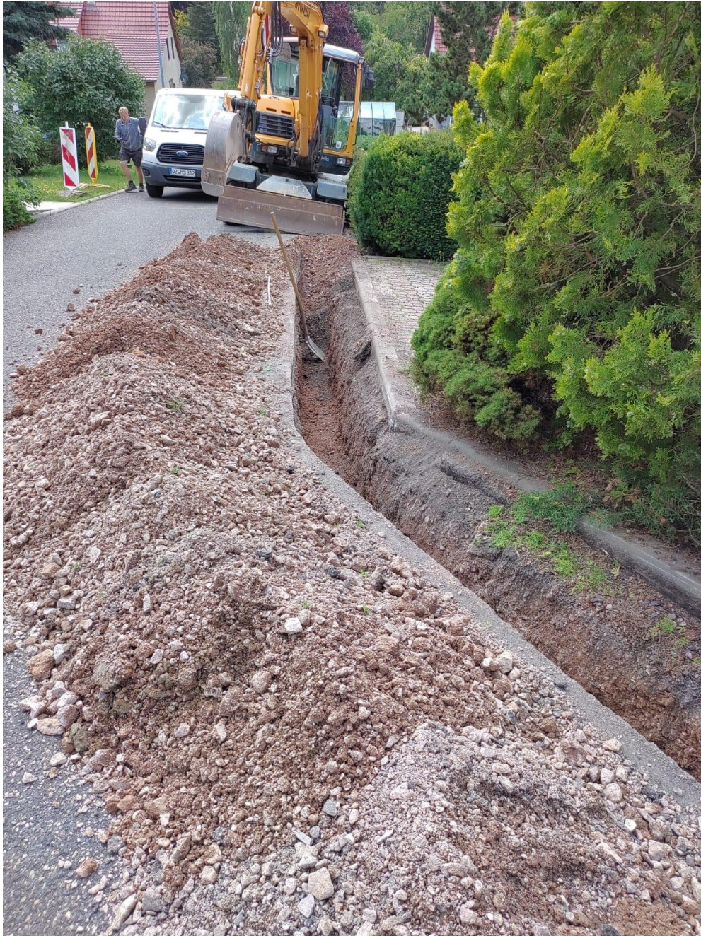
Mitarbeiter der Fa. Mike Schulze bereiten die Verlegung der Glasfaserverbände Am Südhang in Burkhardswalde vor.
