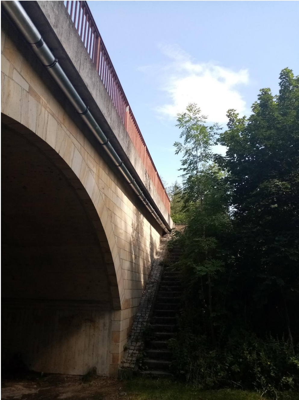
An der Brücke in Rothschönberg nach Grotzsch wurde eine Anhängung für die Versorgungsleitungen installiert.
