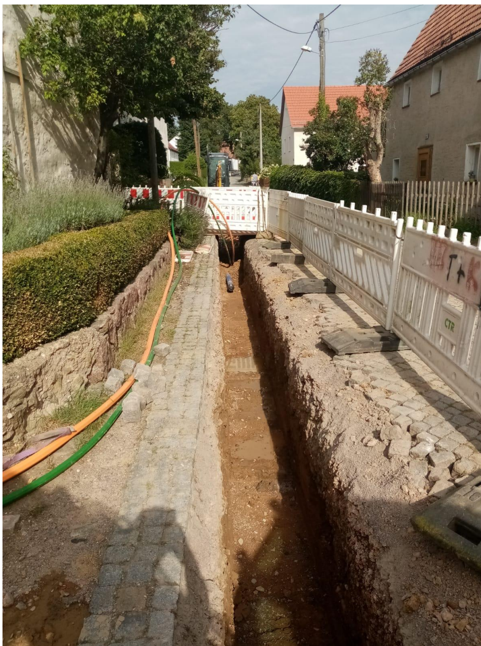
In Polenz wird neben dem Breitband auch die Trinkwasserleitung neu verlegt.
