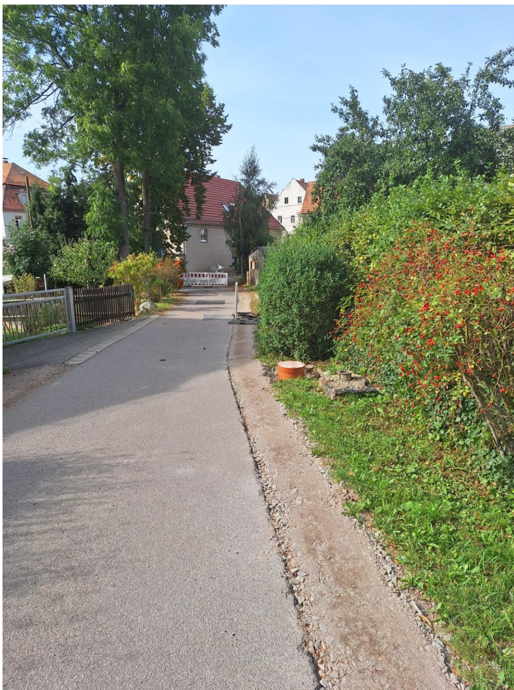
Auf der Hofegasse in Polenz wurden drei neue Lampenstandorte vorbereitet.
