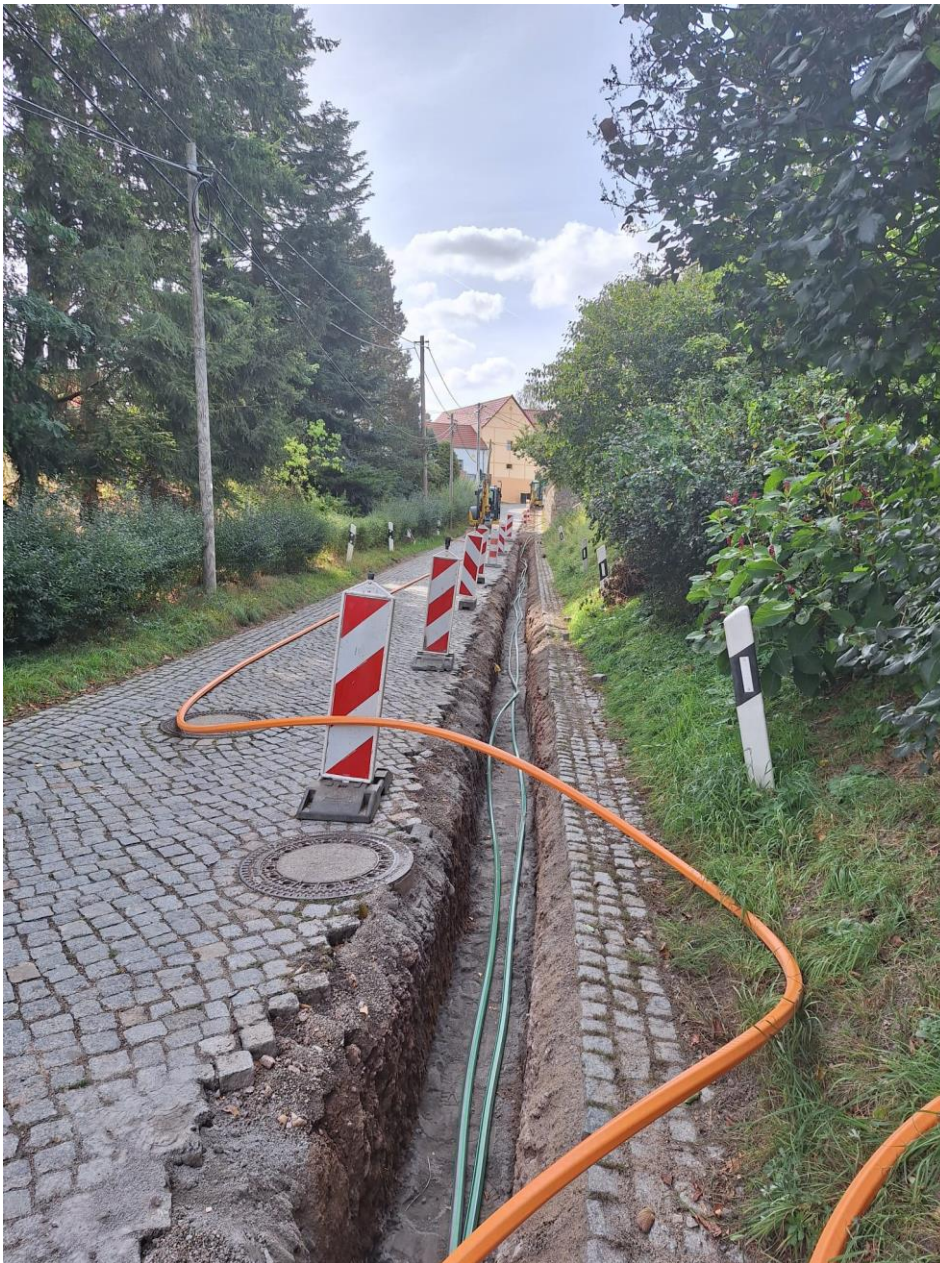
Breitbandverlegung auf der Polenzer Hauptstraße in Polenz
