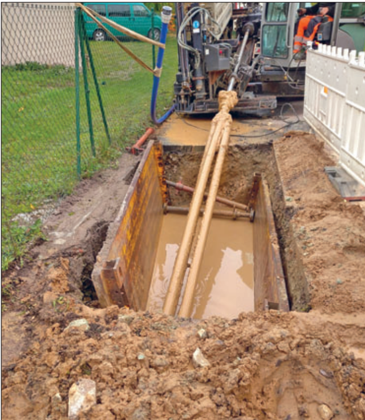
Die Walkmühle in Garsebach wurde mittels Horizontalspülbohrung unterhalb der Bahnlinie mit Breitband, Trinkwasser und Strom neu erschlossen.
