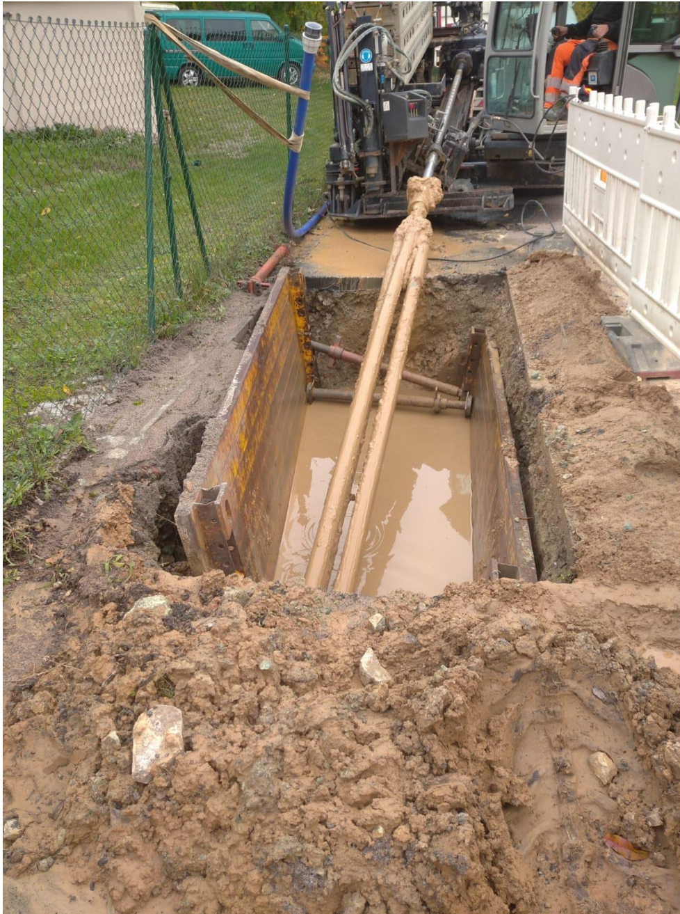
Die Walkmühle in Garsebach wurde mittels Horizontalspülbohrung unterhalb der Bahnlinie mit Breitband, Trinkwasser und Strom neu erschlossen.
