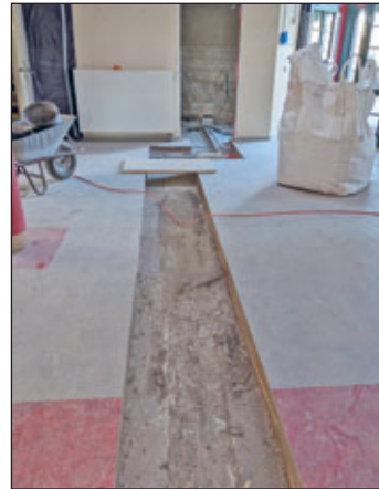
Entkernte Leitungstrasse Foyer
