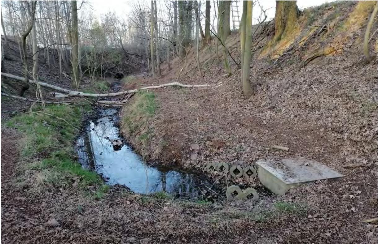
Abb. 7: kurzzeitig offen fließender Bachabschnitt am Süden des Plangebietes, der Durchlass im Hintergrund führt unter der BAB 4 hindurch, der Ein-/Auslauf im Vordergrund führt in eine unterirdische Wasserführung unterhalb der angrenzenden Ackerflächen
