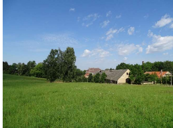
Abb. 8: Blick auf die nordwestlich gelegenen Gebäude des Rittergutes
