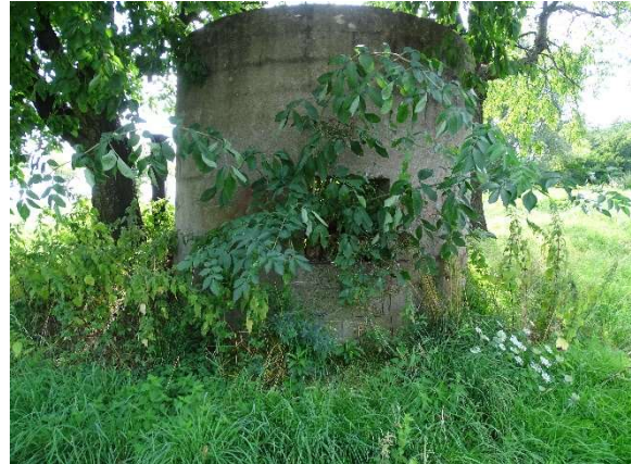
Abb. 16: Betonreste an der Straße „Zum Rittergut“
