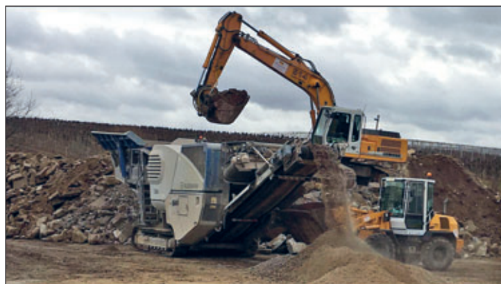
Bagger, Radlader und Betonbrecher bei der Arbeit
