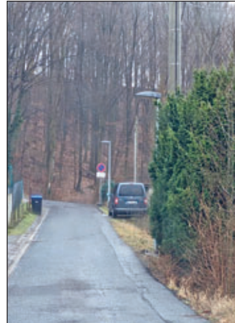
Zwei neue Mastleuchten
