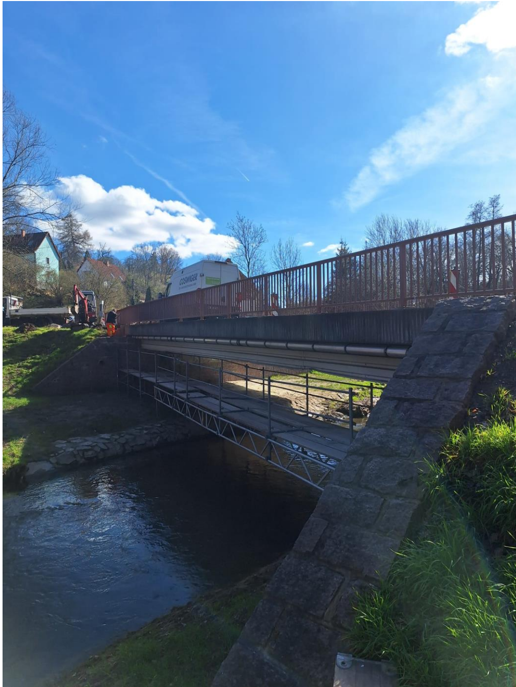
Mitarbeiter der Fa. Coswiger Tief- und Rohrleitungsbau GmbH stellen die Verbindung zum Glasfaserverteiler in Robschütz mittels einer Brückenanhängung her.
