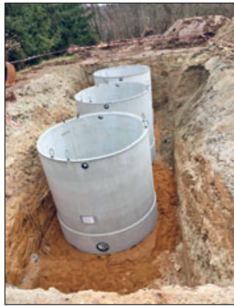
Zisternen in der Baugrube
