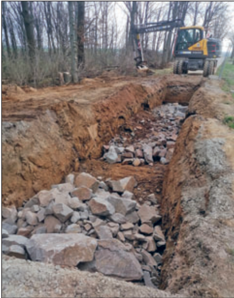
Auffüllung mit Bruchsteinen
