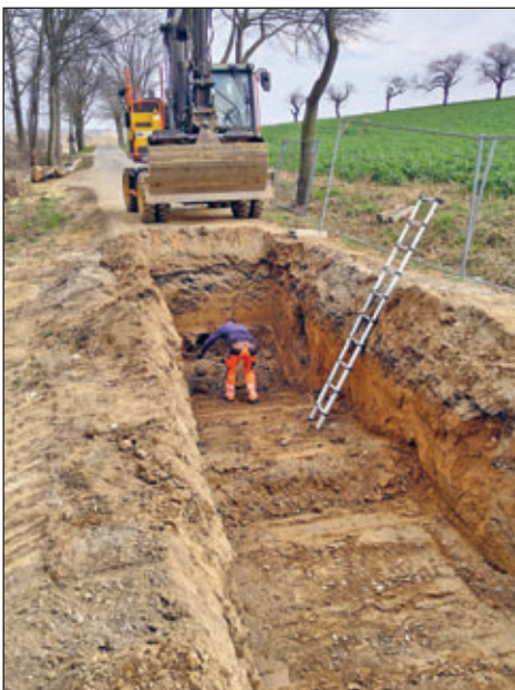
Baugrube in der Straße
