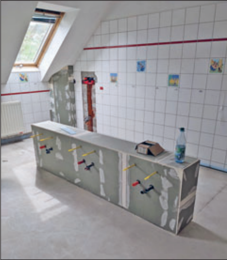
Sanitärbereich mit neuer Vorwand
