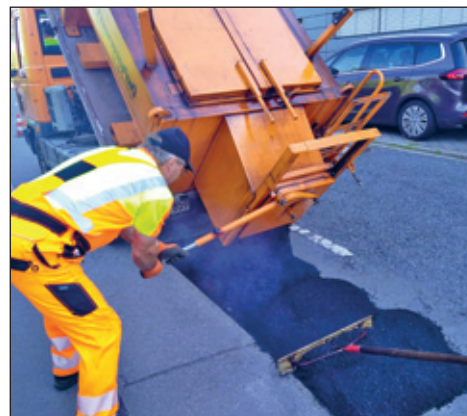
Einbau des Asphalttes
