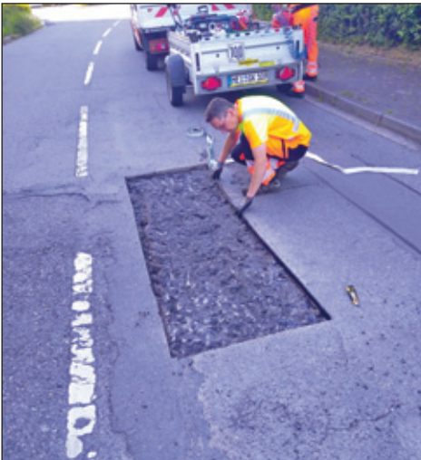
Einbau des TOK Bandes
