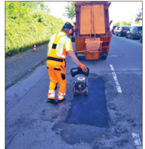
Verdichten des Asphalttes
