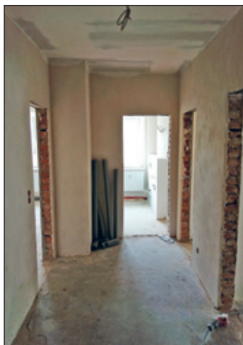
Wohnung während Sanierung
