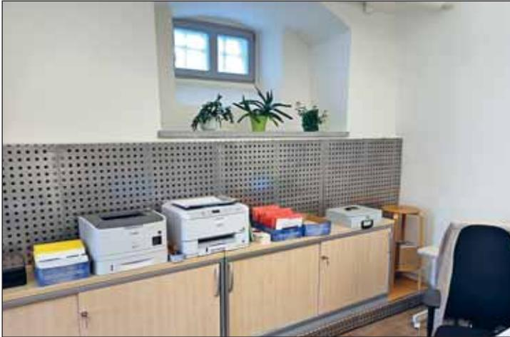
reich entfernt und bis auf das Bruchsteinmauerwerk abgeschlagen. Um für ein stetiges Ablüften der Oberflächen zu sorgen, wurde die Fläche mit einer Lochblechwand verblendet. So wird ein steter Luftstrom ermöglicht, welche dafür sorgt, dass das Bruchsteinmauerwerk abtrocknet und es nicht zu Feuchtigkeitsstau auf den Oberflächen kommt.
