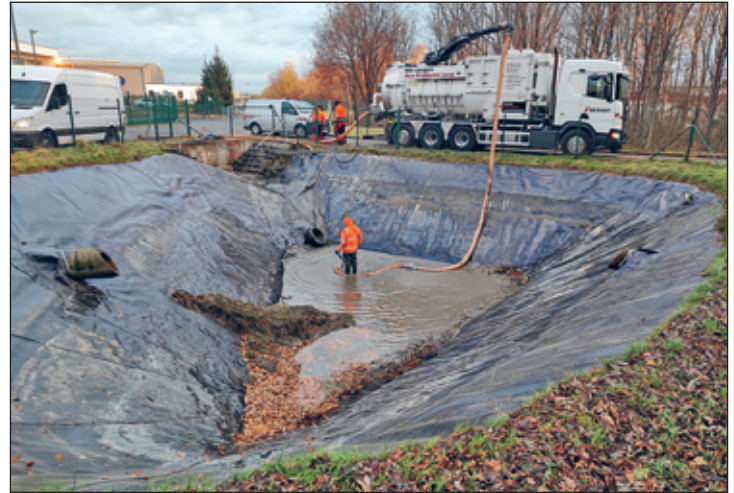
Saugbagger bei der Arbeit
