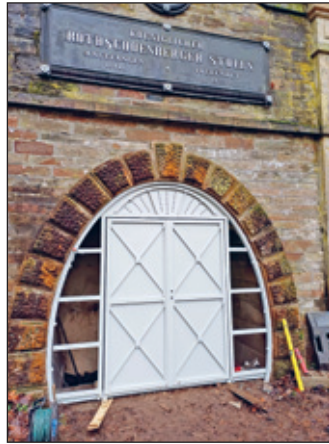
Stollntor während der Sanierung
