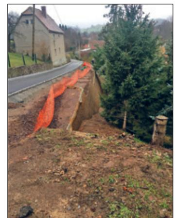
Böschungssicherung mit bewehrter Erde
