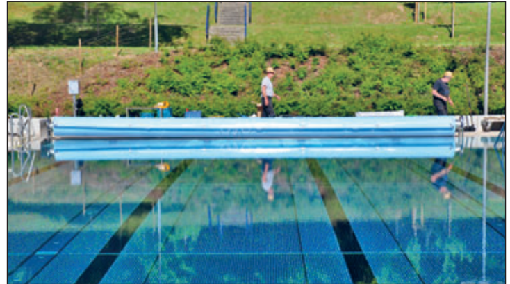
Am Ende der 25 Meter-Bahn wurde die Rolle für die Abdeckplane montiert.
