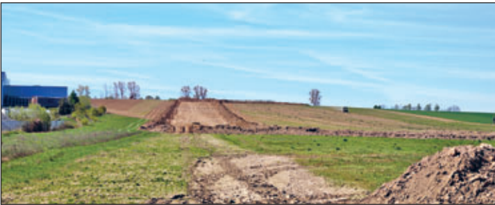
Begonnene Baufeldfreimachung im Bereich der neuen Erschließungsstraße
