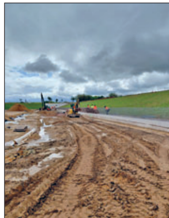
Blick in das Retentionsbecken
