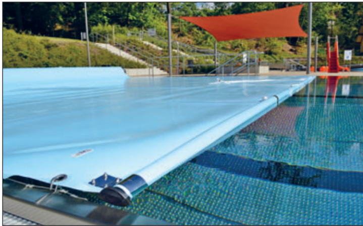
Die Abdeckung wird eingerollt. Das dauert etwa sieben bis acht Minuten
