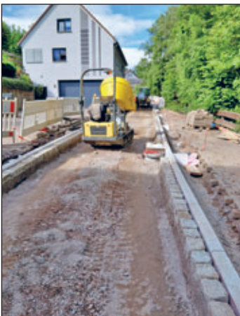
Einbau Borde und Randeinfassung
