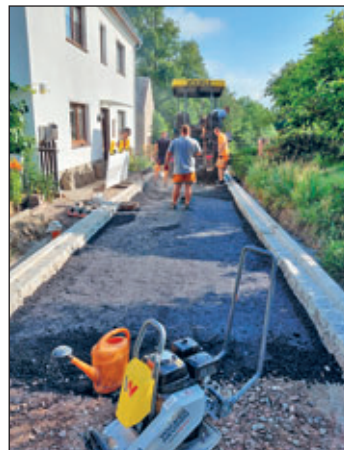
Beginn der Asphaltarbeiten
